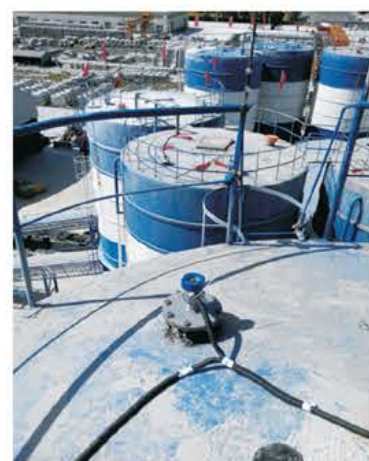
混凝土搅拌站
