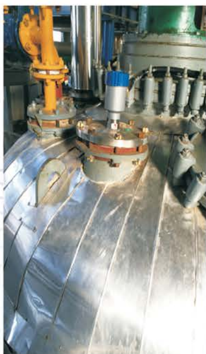
反应釜液位测量
