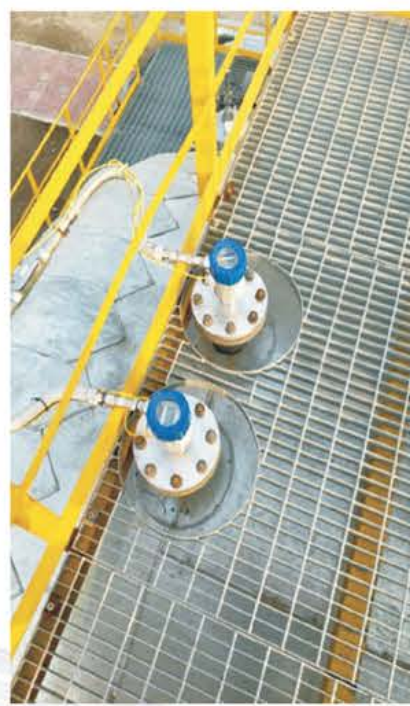
化工厂储罐液位
