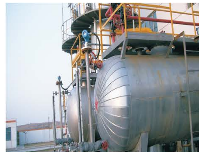
旁通管油位测量
