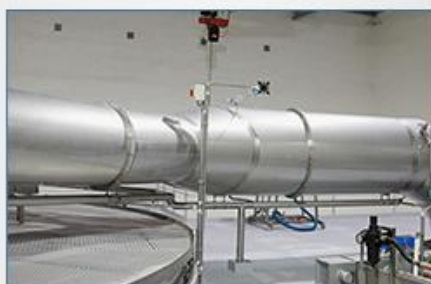
地下管道监控
