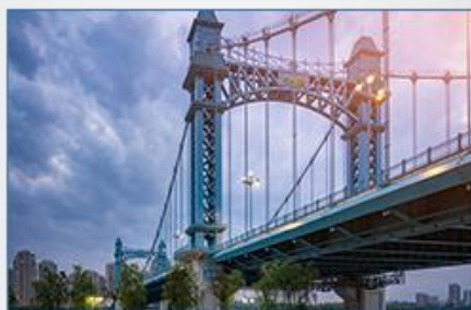
桥梁建筑物监测
