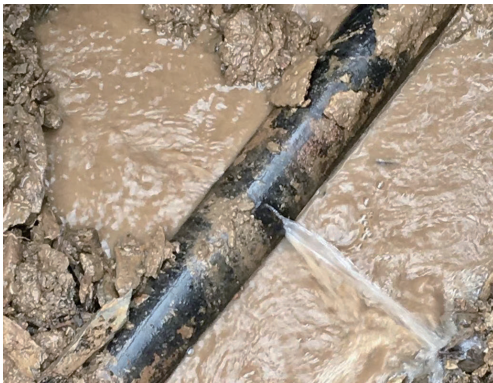
根据管道自来水泄漏的噪声寻找泄漏点
