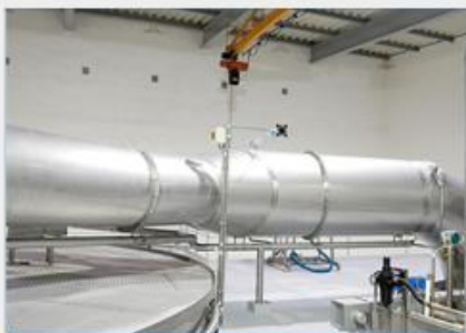
地下管道监控
