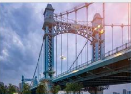
桥梁建筑监测
