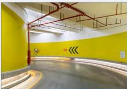
隧道收敛监测
